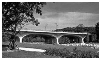
写真1 公園と調和した 道路橋
