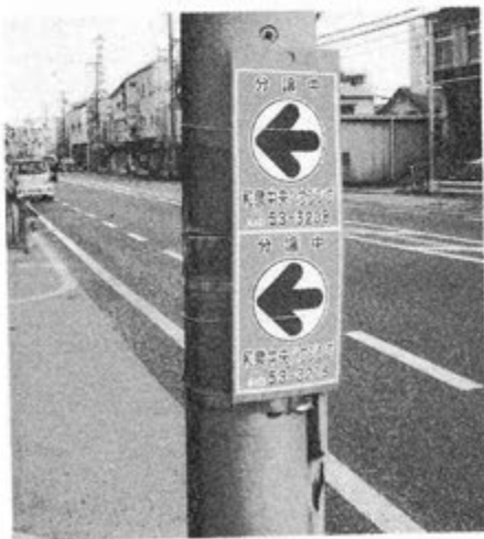
←巻き付けていないし、地上から最下端までの距離が2.3m以上あいていないため、違法広告物だ。
