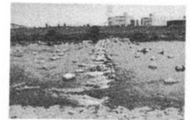
〈平野区長吉の瀬と瀬浄化施設〉
