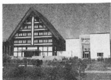
内藤記念くすり博物館 所在地 岐阜県羽島郡川島町 エーザイ川島公園内 TEL 058689-2101
