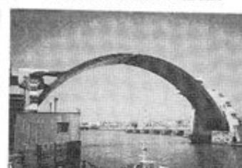
▲写真14 安治川水門
