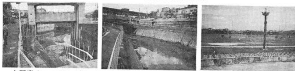
▲写真4 ポンプ場 ▲写真5 京阪萱島駅 ▲写真6 寝屋川市治水緑地
