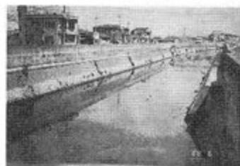
▲写真7 住道大橋
