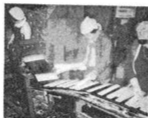
▲写真5 断裁 短冊状の板にする。 幅約5cm。
