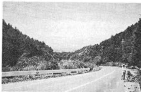
▲写真14 新国道（臨海工業地帯を望む）
