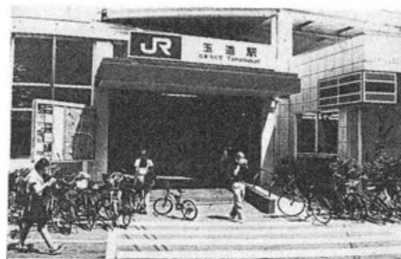
▲写真⑬ 玉造駅の出入口の所
