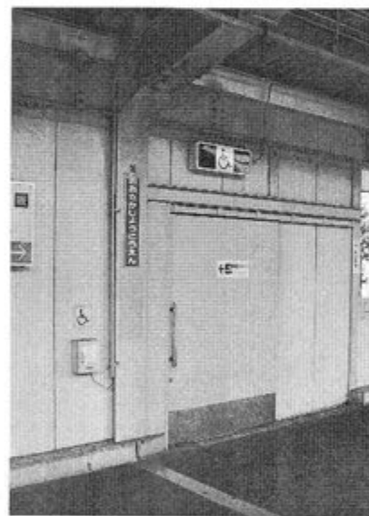
▲写真⑧ 大阪城公園駅のホームにある扉
