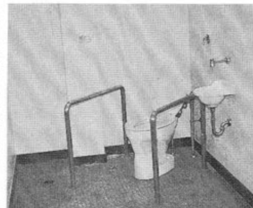
▲写真④ 障害者用トイレ
