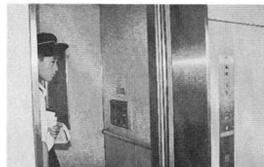
▲写真③ エレベーター
