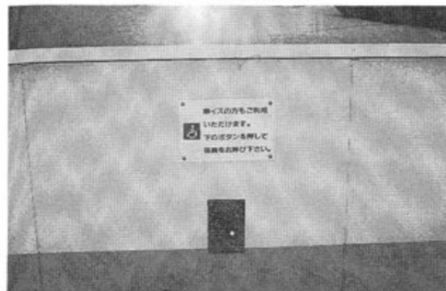
▲写真⑦ 弁天町駅のホームにあるインターホン
