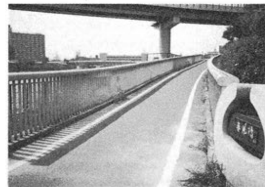
▲写真3 春風橋とそのながめ
