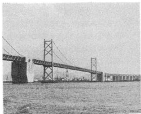
▲写真4 南備讃瀬戸大橋（吊り橋）
