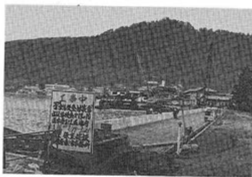
▲写真3 江尻・浸食対策工事 (内海)
