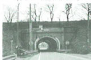
写真6 百瀬川隧道②
