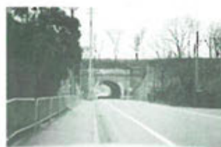
写真5 百瀬川隧道①
