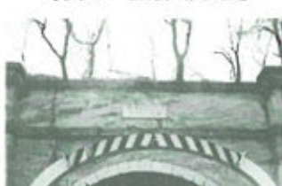
写真7 百瀬川隧道③
