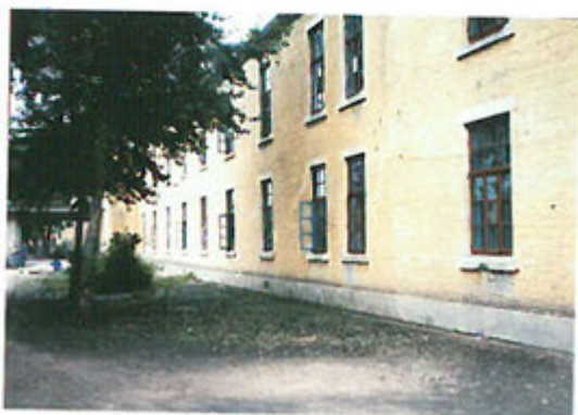
陈列馆の外観(かつての731部隊の建物の一部)
