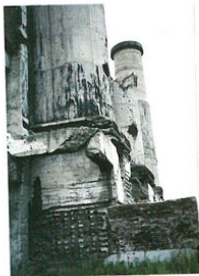
爆破することができなかった ボイラ室の煙突
