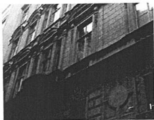
モーツァルトの死んだ家 (ウィーン)
