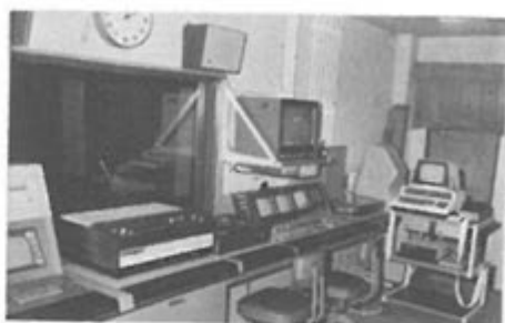
1. 機械室内の調整卓及びコンピュータ等
