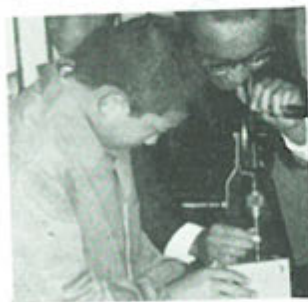
ハンドドリルによる 穴あけ作業
