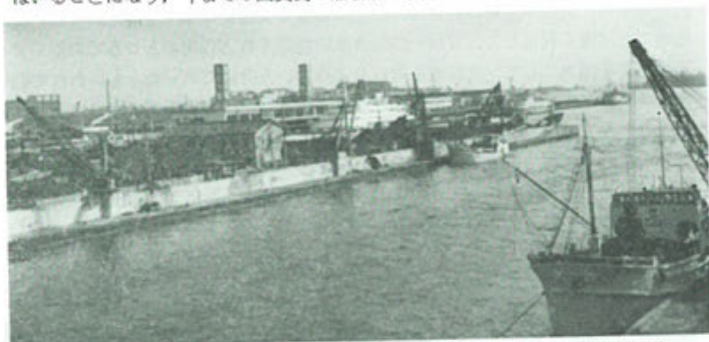
現在の安治川（内港計画によって拡張した。正面むこうが弁天埠頭である）
