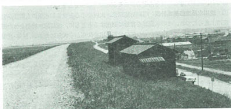
淀川堤防上の水防区材料置場と屯所
