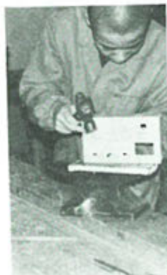
タガネによる 切断作業
