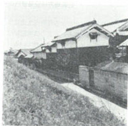
水防を考えた家屋の構え（上段は寝屋川市対馬江，下段は枚方市伊加賀）
