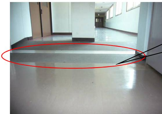
段差があるので危険。段差に気づけるよう段差のはじまりと終わりに黄色で塗装する。
