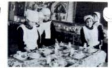
<現在の園舎になってからのようす>
